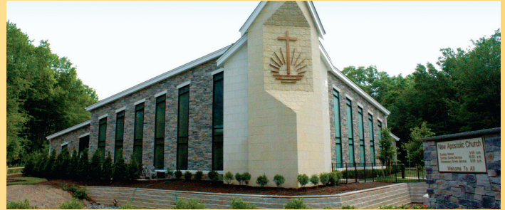
La iglesia terminada en Parsippany, NJ
