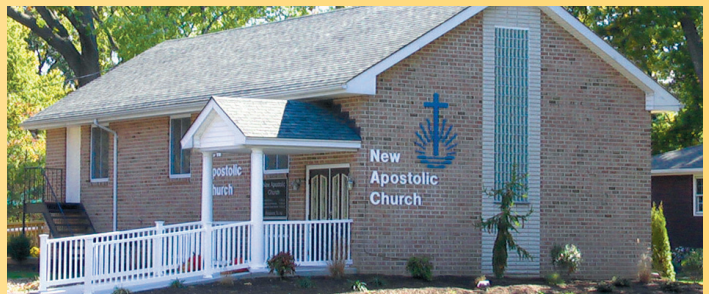
Renovación de la iglesia en Cinnaminson, NJ
